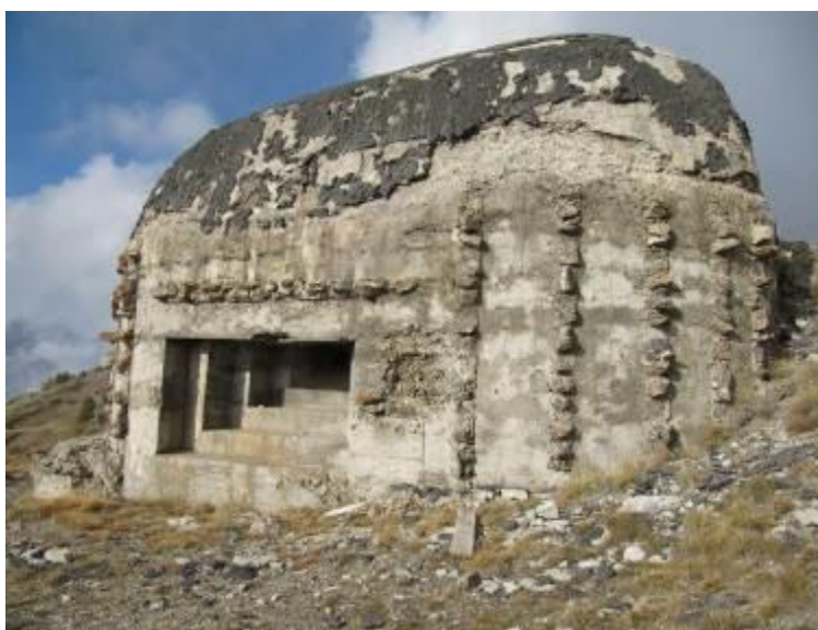
Ouvrage 211 – Photo de Luca Grande
